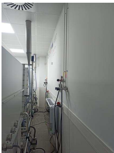
Figura 10. Imagen de los puntos de consumo de la caja de guantes CIRCULARCARBON
