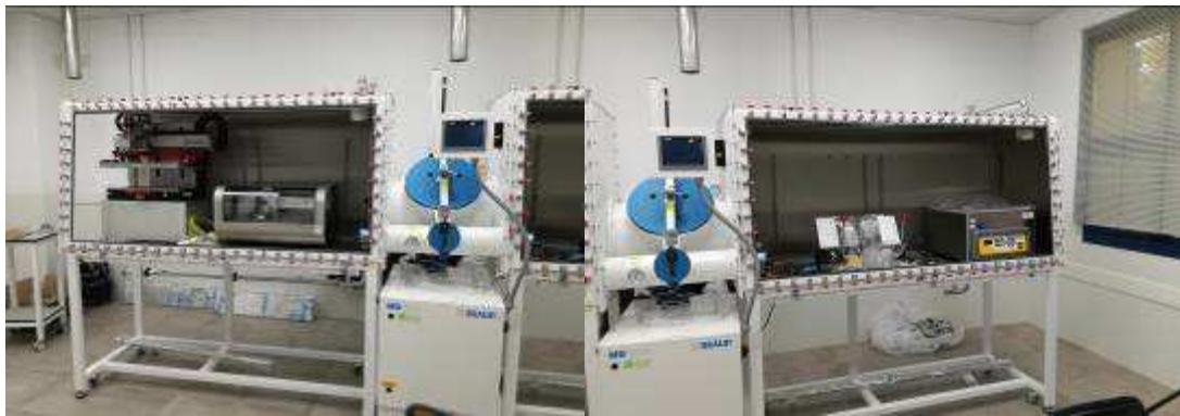
Figura 13. Fotografías de la caja de guantes con el equipamiento situado en el interior antes de la colocación del panel frontal.
